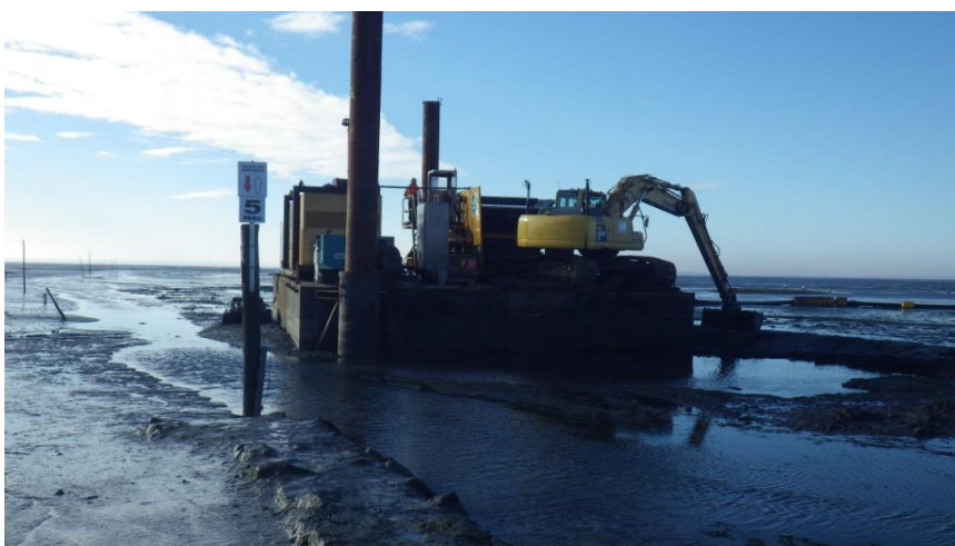
Figure 4 : Extraction en eau (exemple des travaux de 2015 dans le chenal de Fontainevieille)
